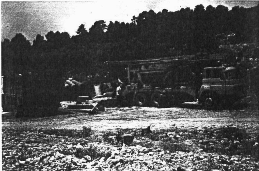
Foto 10: Sondeo de explotación a percusión de la Alternativa E (Aguascebas).
