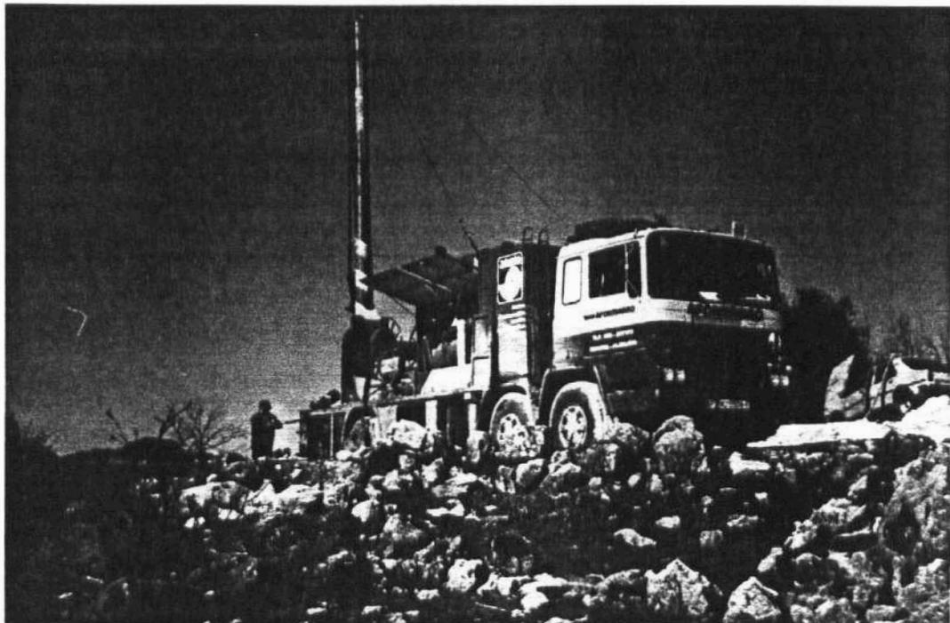
Foto 30: Primer ensayo de bombeo en el sondeo de explotación I (El Alemán), antes de la acidificación.
